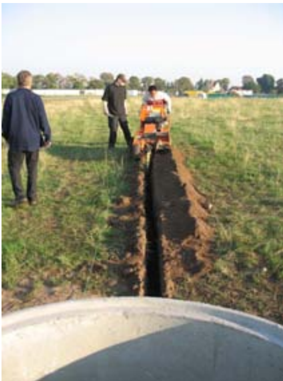
Abb. 4.2-2: Herstellen des Verlegegrabens mit einer Grabenfräse
