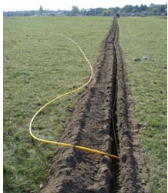
Abb. 4.2-3: Verlegung des Messsystemschlauchs
